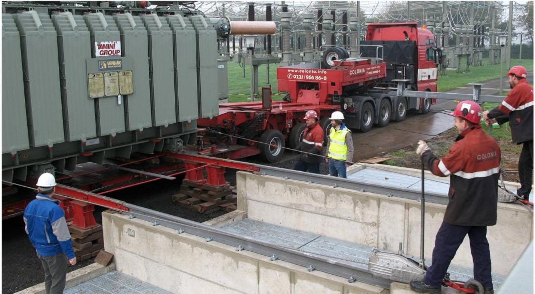
Einbringung eines neuen 110 kV-Trafos in der Umspannanlage Goch-Pfalzdorf (Okt '15)
