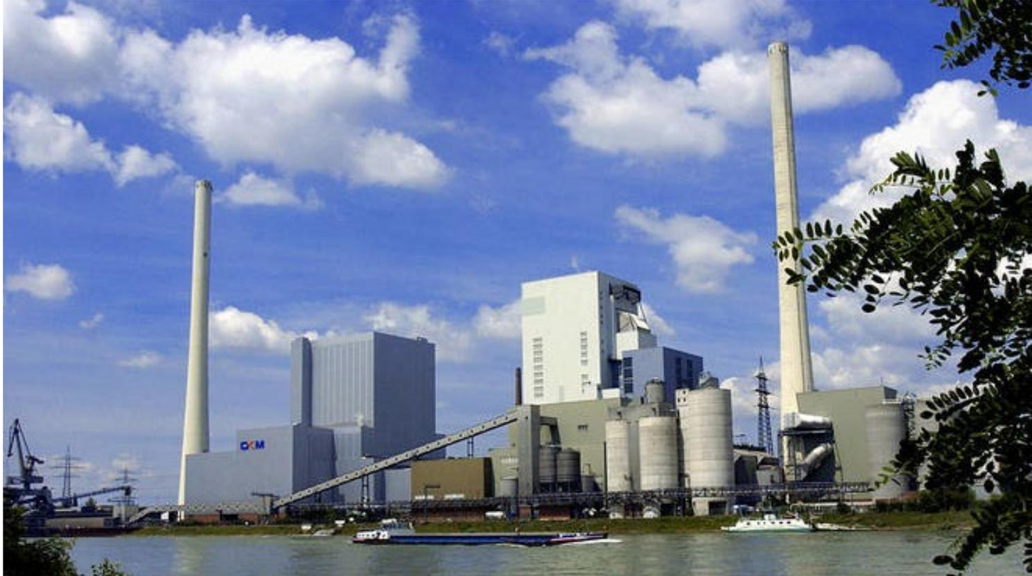
Kohlekraftwerk Block 9 (2015). Dampfdaten: 290 bar, 600°C (20bar)
