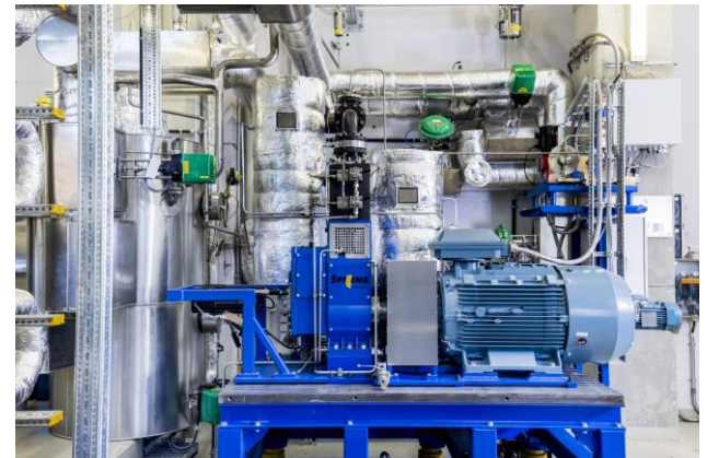
TMS-Batterie und 1 Zyl.-Verdichter
